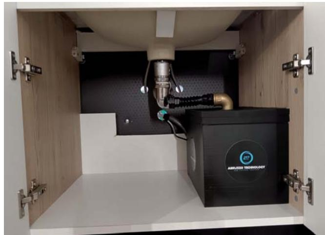
serbatoio stesso che può essere di dimensioni variabili, in funzione dell'accumulo desiderato e dello spazio a disposizione. L'acqua accumulata, poi, arriva direttamente all'interno della vaschetta del wc e può essere utilizzata al posto della rete idrica potabile. Il sistema di alimentazione è completamente automatico. Il serbatoio è componibile e la parte superiore è rimovibile, in modo da permettere pulizia e interventi di manutenzione.
